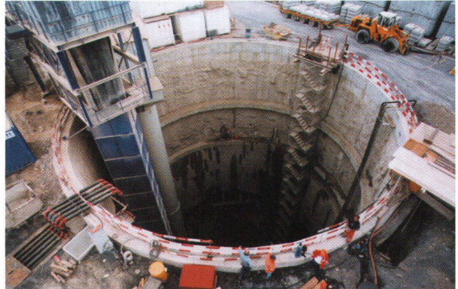
Abb. 2: Startschacht Brunau, Zürich.
