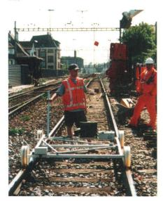
Abb. 7: Gleismesswagen.
