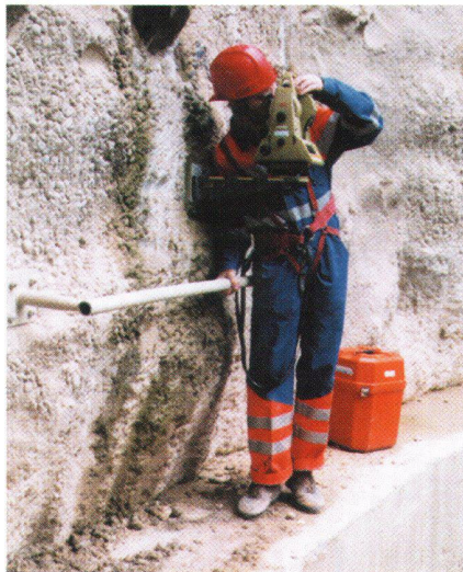
Abb. 3: Winkelübertragung im Startschacht Brunau.
