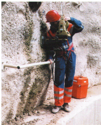
Abb. 3: Winkelübertragung im Startschacht Brunau.
