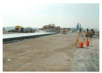
Abb 1: GOMACO Beton-Gleitschalungsfertiger gesteuert durch das Leica Maschinenleitsystem.
