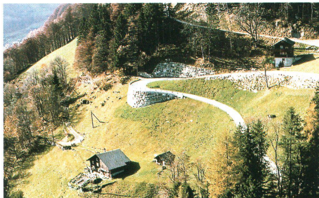
Abb. 4: Steigungen sollten zwölf Prozent nicht übersteigen. Dies bedingt Wendepunkten und Blocksteinmauern, die sich gut ins Gelände einfügen.
