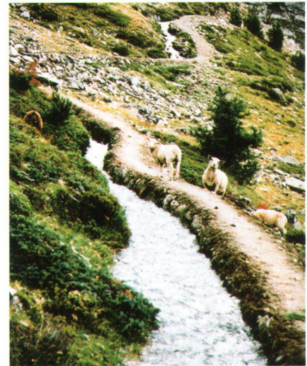
Abb. 5: In Tretschbord sanierte Wasserleite in einfachem Gelände (Fotos 5 und 6: Ing.büro Furrer + Heinzmann, Visp).
