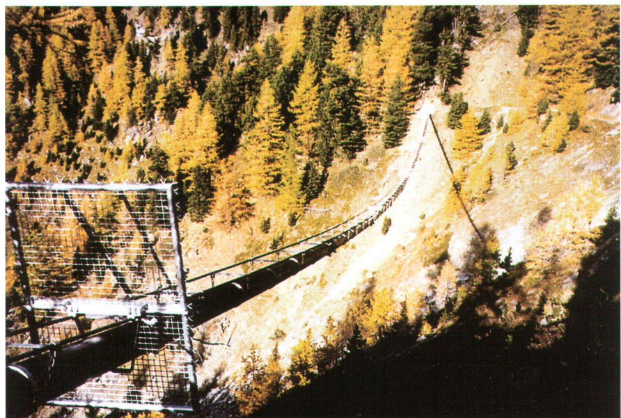
Abb. 6: In luftiger, aber sicherer Höhe wird der Lawinen- und Rutschhang von Lengfell mit einer Rohrbrücke überquert.
