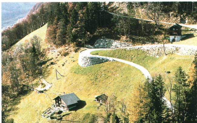
Abb. 4: Steigungen sollten zwölf Prozent nicht übersteigen. Dies bedingt Wendepfaden und Blocksteinmauern, die sich gut ins Gelände einfügen.
