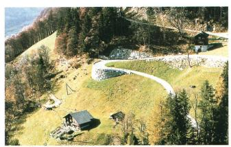
Abb. 4: Steigungen sollten zwölf Prozent nicht übersteigen. Dies bedingt Wendeplatten und Blocksteinmauern, die sich gut ins Gelände einfügen.
