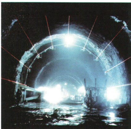
Abb. 3: Tunnelvermessung.
