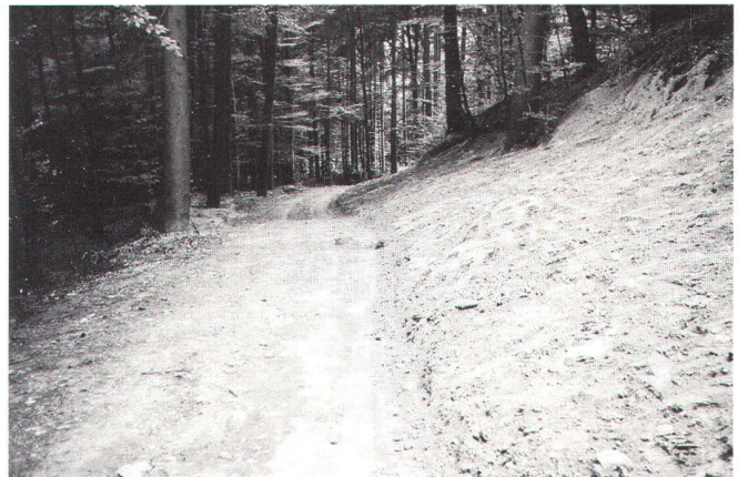
Abb. 6b: Die Schorgass 1994, gleicher Aufnahmestandort wie Abb. 6a. Der Hohlweg wurde komplett mit Aushubmaterial aufgefüllt. Damit sollte eine bessere Befahrbarkeit erzielt werden und der Wasserabfluss in der Wegsohle verhindert werden (Foto: Andreas Flury 14.7.1994).
