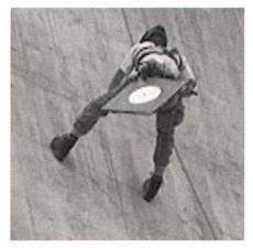
Abb. 2: Anbringen der Zielmarken an der Staumauer.
