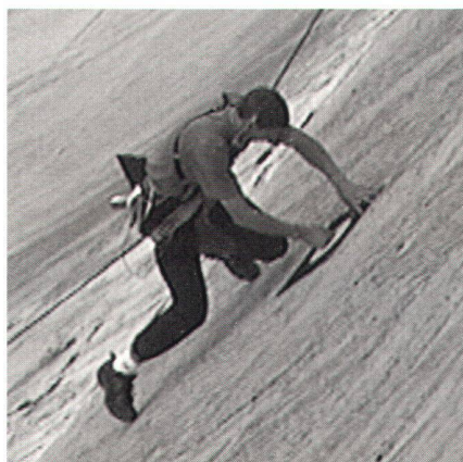
Abb. 2: Anbringen der Zielmarken an der Staumauer.
