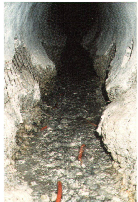
Abb. 2: Zustandsaufnahme mittels Kanal-TV.
