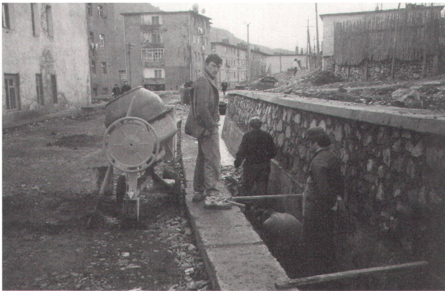
Abb. 3: Baustelle Infrastruktur-Programm: Meteorwasserkanal und Quartierstrasse.
