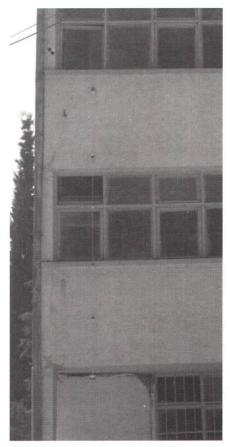
Abb. 5: Verwendetes Lot als Information über den Massstab und die Vertikale.
