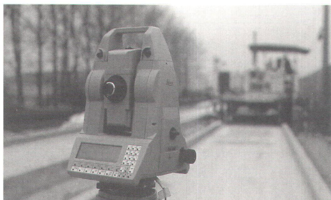
Abb. 2: Einsatz einer automatischen Leica Totalstation TCA1800 zur Führung eines Gleitschalungsfertigers.
