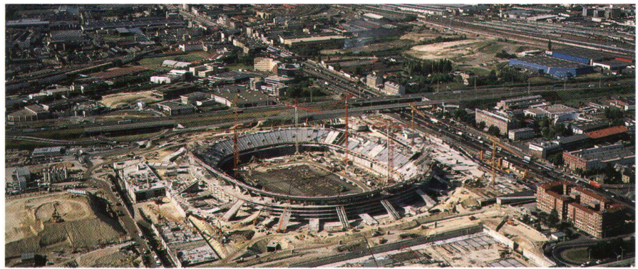
Abb. 10: Die Grossbaustelle im Juni 1996.
