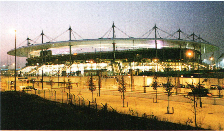
Abb. 1: Sieben Meter unter dem alten Geländeniveau liegt die Arena. Jacques Brottier von der «CIE Stadionbau» schuf ein Festpunktnetz auf Betonpfeilern, eingemessen mit Leica Tachymetern und Leica GPS-Systemen.
