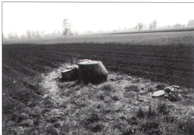
Abb. 4: Werksversagen sekundärer Art: Humuszehr, Höhenverlust, Durchlässigkeitsverminderung.
