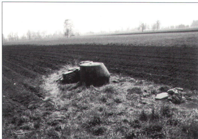
Abb. 4: Werksversagen sekundärer Art: Humuszehr, Höhenverlust, Durchlässigkeitsverminderung.
