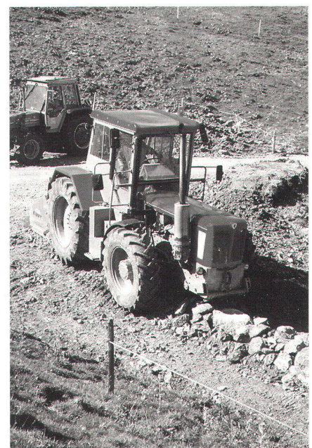
Abb. 2: In ein bis zwei Durchgängen bereitet der traktorgezogene Kirpy das Koffermaterial aus dem Vortrieb an Ort auf. (Foto: F. Walder, Kt. Melio-rationsamt SZ).
