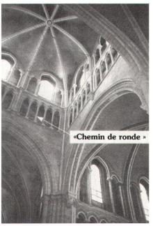
Fig. 2: Aperçu des chemins de ronde intérieurs.
