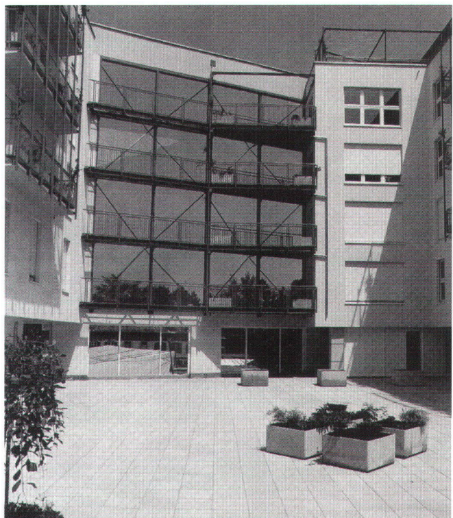
Abb. 2: Neubau reagiert auf Lärmsituation: Hauptorientierung gegen geschlossenen Innenhof (Luzern). Links: Gesamtansicht, rechts: Innenhof.
