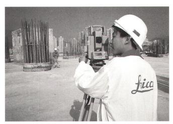
Stahlbetonpfeiler-Einmessung auf dem Tsing-Yi-Bahnhof mit Tachymeter Leica TC 1010. Auch Hochbauten bestimmen in beträchtlichem Umfang das Flughafen-Projekt. Hier auf der Insel Tsing-Yi entsteht im Moment in Mitte der Flughafen-Gesamtstrecke der erste Bahnhof dieser Insel. Er soll zu ihrem Verkehrs-, Erlebnis-, Einkaufs- und Kulturzentrum werden. Leica-Instrumente sind Standard bei dem in vier Sektionen unterteilten MTRC-Vermessungsprojekt der Flughafen-Eisenbahnlinie.
