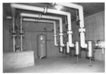
Abb. 3: Zentrale Grundwasserfassung für Wärmepumpen einer Einfamilienhausüberbauung (Foto: F. Beyeler).
