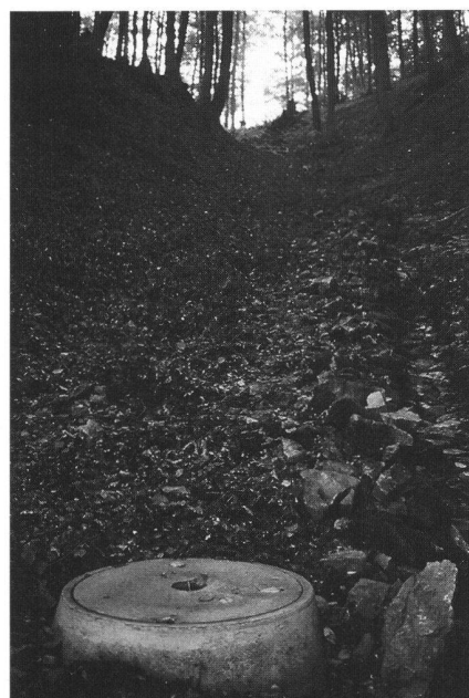
Abb. 4: Ein Kontrollschacht im Wald bleibt als Merkpunkt der Abwasserleitung.
