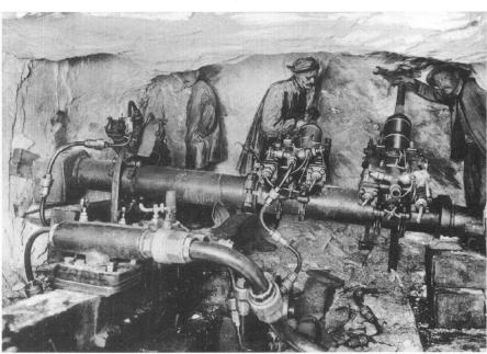
Abb. 3: Brandt'sche Bohrmaschine beim Bau des Simplontunnels.
