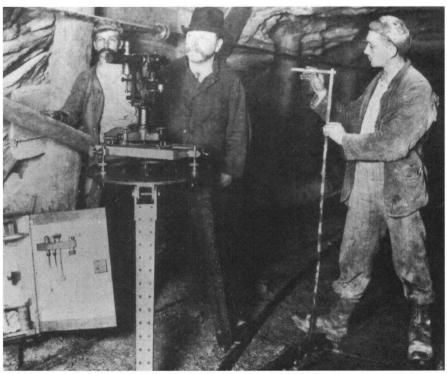
Abb. 1: Vermessung beim Bau des Simplontunnels 1898-1905.
