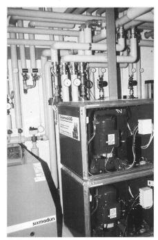
Abb. 3: Heizzentrale mit Wärmepumpe.
