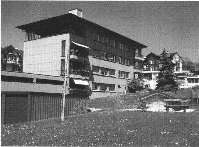
Abb. 1: Eines der drei Mehrfamilienhäuser, die mittels Erdsonde beheizt werden. Vorne rechts: Häuschen mit Erdsondenschacht.
