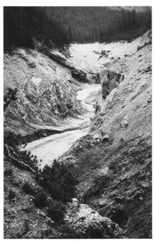
Abb. 1 und 2: Entleertes Staubecken Ova Spin, das mitten in den Schweizerischen Nationalpark eingebettet ist. Das aus der Seewurzel zufliessende Spülwasser wurde mit grosser Frischwassermenge, die über den Freispiegelstollen zugeleitet wurde, effizient verdünnt. Am rechten Bildrand ist die Mündung des Freispiegelstollens mit dem abstürzenden Innwasser ersichtlich. (Foto: Engadiner Kraftwerke AG [EKW], Zernez/GR.)
