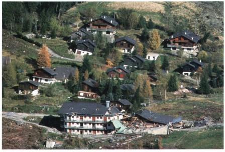
Fig. 5: Glissement de «Falli-Hölli» (FR); une meilleure gestion du territoire devrait permettre d'éviter de telles catastrophes. Le site en glissement a été surveillé par mesures GPS.
