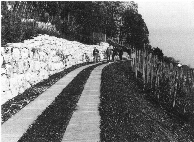
Abb. 1: Rebbergmelioration La Neuveville - Schafis, BE: Als Spurweg ausgebauter Rebweg mit naturnahen Blockmauern im BLN-Gebiet Linkes Bielerseeufer (Photo A. v. Waldkirch, kant. Meliorationsabteilung Bern).
