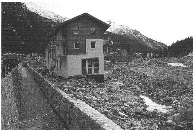
Abb. 2: Beispiel für Bauten im Gefahrengbiet ohne Rücksicht auf die Gefahrensituation.
