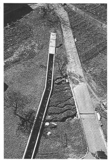
Abb. 6: Beispiel eines verbetonierten Bachlaufes.
