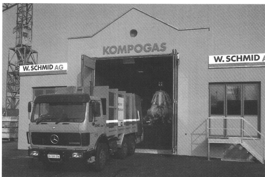
Abb. 5: Kompogasanlage in Rümlang.
