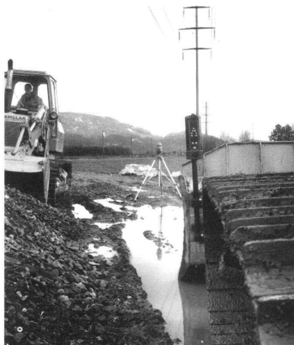
A l'aide du récepteur laser MCR12, le conducteur peut positionner la lame de l'engin de façon sûre et rapide.
