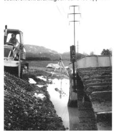
A l'aide du récepteur laser MCR12, le conducteur peut positionner la lame de l'engin de façon sûre et rapide.
