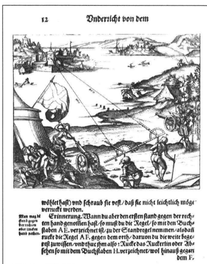
Abb. 4: Distanzbestimmung mit Hilfe des Zublerschen Halbkreisinstrument mit zwei Alhidaden (1607) für das Schiessen der Artillerie.
