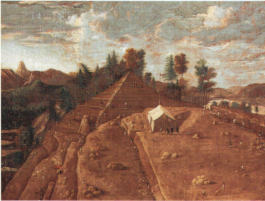
Abb. 6: Arbeiten am Kanderdurchstich 1711/12. Zeitgenössisches Ölgemälde. Anonym. Photographie: S. Rebsamen (Bernisches Historisches Museum, Inv.-Nr. 5067).
