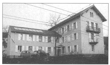
Fig. 3: Immeuble d'habitation à la rue Saint-Nicolas 22: L'assainissement réalisé en 1994 a consisté en: isolation des façades et de la toiture; remplacement des fenêtres par und double vitrage isolant avec couche sélective; préchauffage de l'eau chaude sanitaire par 18 m² de capteurs solaires thermiques; remplacement des calorifères individuels par une chaudière à gaz. L'économie d'énergie thermique est de 6900 m³ de gaz/an, soit une réduction de 55% par rapport à 1993.
