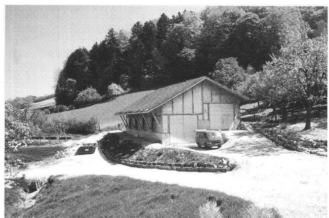
Abb. 2: Der Schafstall. In sein Süddach (Hangseite) soll im Spätsommer die Photovoltaikanlage integriert werden.
