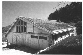
Abb. 1: Auf das begrünte Süddach des Wohnhauses wurden 36 m² thermische Kollektoren montiert (Fotos: Eric de Lainsecq).
