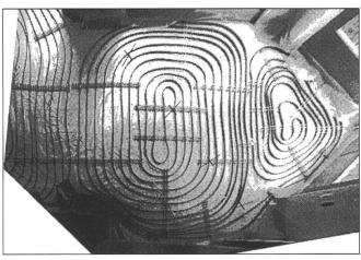
Abb 5b: Fussbodenheizung nach Entzerrung.
