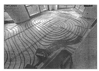
Abb. 5a: Schrägaufnahme Fussbodenheizung.
