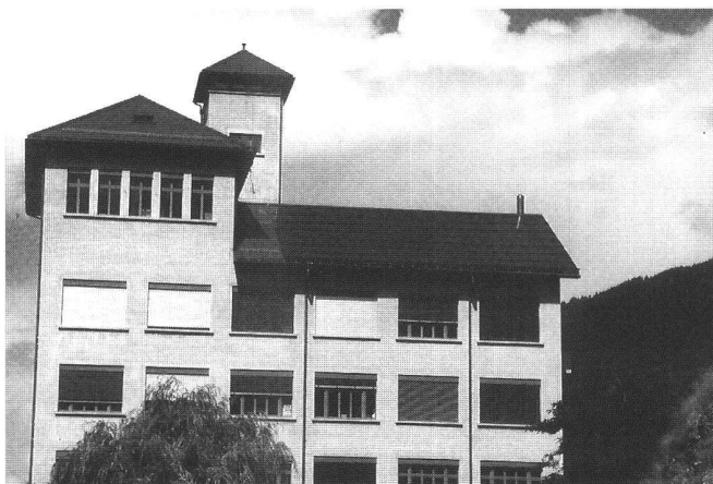
Abb. 8: Getreidemagazine der Eidgenössischen Getreideverwaltung in Brig mit Photovoltaikdach.
