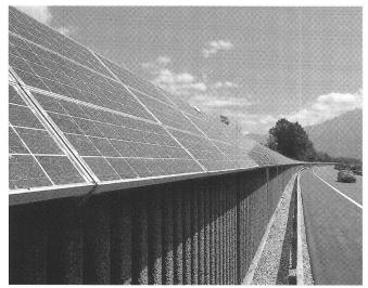
Abb. 3: Photovoltaik-Lärmschutzwand an der N 13 bei Domat/Ems.
