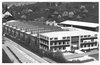
Abb. 6: Aerni Fenster AG in Arisdorf: Photovoltaikanlage auf dem Sheddach des Fabrikgebäudes und fassadenintegrierte Solarzellen am Bürogebäude.
