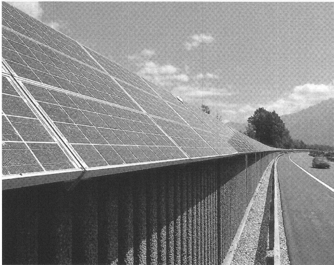
Abb. 3: Photovoltaik-Lärmschutzwand an der N 13 bei Domat/Ems.
