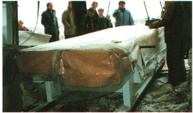
Abb. 14: Ein zwei Tonnen schwerer Druckmaschinen-Teil auf dem Weg durch die herausgebrochene Hauswand in den Druckraum.
