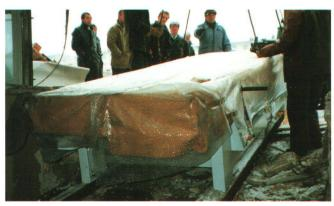
Abb.14: Ein zwei Tonnen schwerer Druckmaschinen-Teil auf dem Weg durch die herausgebrochene Hauswand in den Druckraum.
