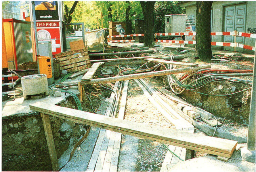
Abb. 2: Elektrizitäts-Trasseebau.
