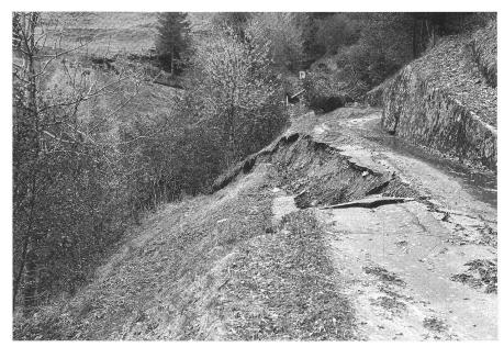
Abb. 1: Unwetterschäden 93, Campo Blenio (TI), Güterweg bei Pianchera. Die Unwetterschäden in den Kantonen TI und VS wurden 1994 mit Hilfe von Sonderkrediten grösstenteils behoben. (Photo: M. Giamboni, studio tecn. d'arch. Imperatori e Giamboni SA, 6715 Dongio.)
