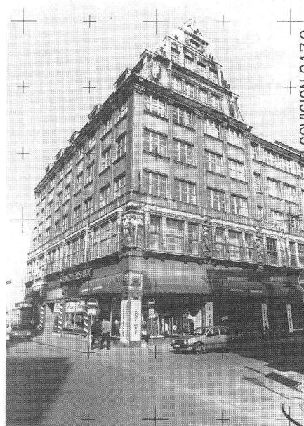
puis 2 points de prise de vue différents. Une ou plusieurs distances connues dans l'objet permettent la mise à l'échelle du modèle. Les points identiques sont digitalisés dans les photos disposées sur une tablette à numériser.
