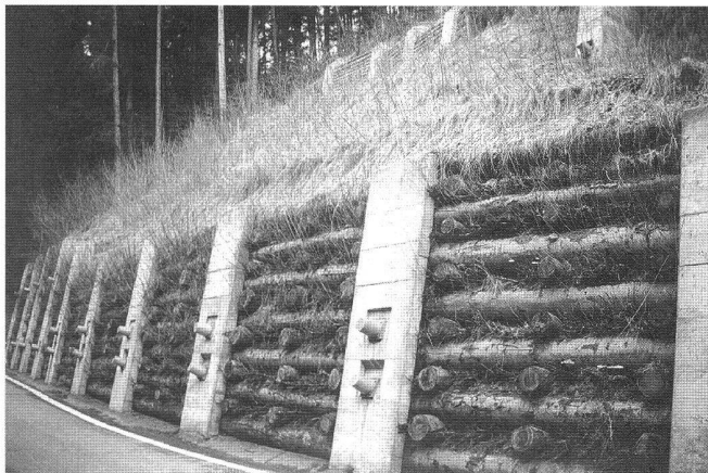
Abb. 5 und 6: Kombination von verschiedenen Methoden: Holzkraierwände wurden zusätzlich mit Betonankern befestigt.
