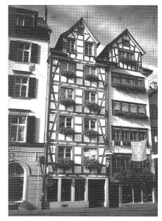
Mit der Einzelbildentzerrung können aus Photographien Pläne von Gebäuden schnell und einfach hergestellt werden. Die Aufnahme des Objekts erfolgt mit einer handels-üblichen Kleinbildkamera. Die Massstabsinformation wird aus gemessenen Strecken oder aus einem Passpunktviereck ermittelt. Hierzu reichen schon die Höhe, Breite und Diagonale einer Tür oder eines Fensters.
