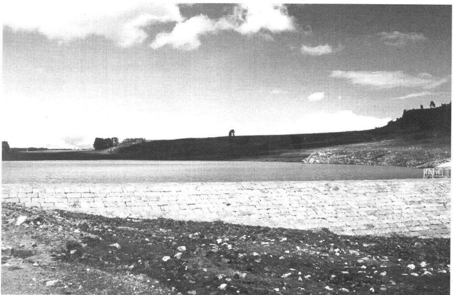
Abb. 5: Fertiger Damm mit gefülltem Reservoir.
