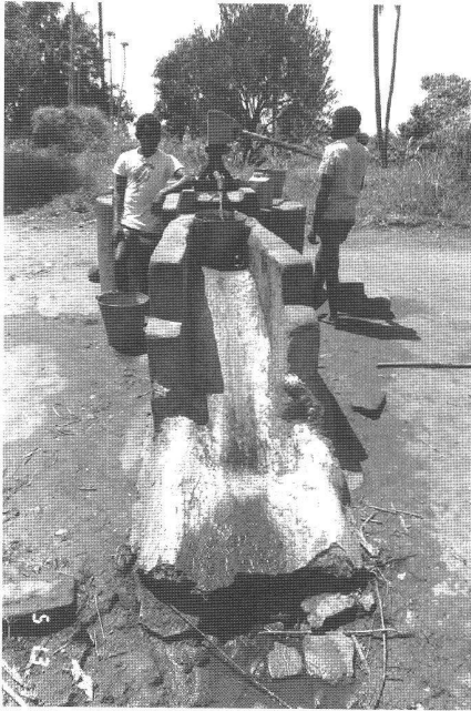
Abb. 2: Einfache Handpumpe als Zapfstelle ausgestaltet, Tanzania, Kilombero Distrikt.
