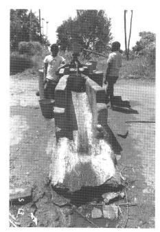
Abb. 2: Einfache Handpumpe als Zapfstelle ausgestaltet, Tanzania, Kilombero Distrikt.
