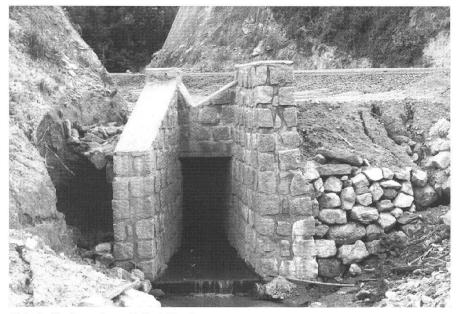
Abb. 5: Madagaskar, «Réhabilitation de la Route National 2»; Bau von Durchlässen durch lokale Kleinunternehmer, die gleichzeitig ausgebildet werden. Die praktische Ausbildung umfasst nebst bautechnischen vor allem auch administrative Abläufe wie Offerterstellung und Bauabrechnung. Regie Konsortium FRISA/Schmalz AG. (Foto: P. Peter, DEH.)
