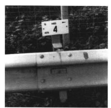
Abb. 4: Bezugspunktschild an bestehender Leitplanke montiert (Bezugspunkt 4 an der Axe TG: H465).
