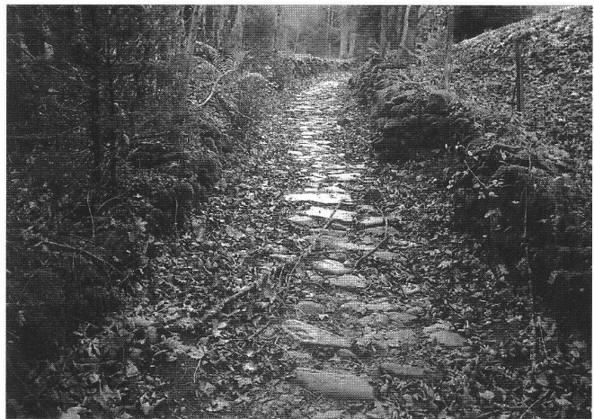
Abb. 2: Historisches Teilstück des Rosenlauer-Wanderweges. Eingemauerter Hohlweg mit gepflasterter Oberfläche: der alte Rosenlauerweg oberhalb «Zwirgi».
