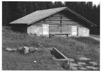
Abb. 1: Saniertes Alpgebäude auf der Bodenalp. Das Alpgebäude präsentiert sich nach der Sanierung wieder mit einem vollständigen Schindeldach.
