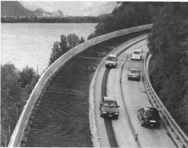
Abb. 3: Rohrregister in der Fahrbahn der N8 bei Därligen.
