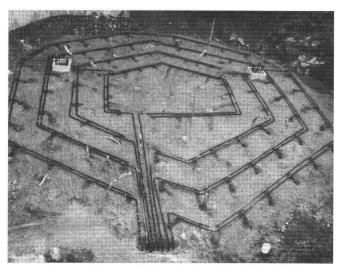
Abb. 4: Erdsonden des Felsspeichers der N8 bei Därligen.
