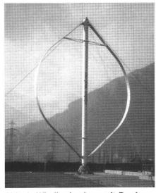
Abb. 2: Windkraftanlage mit Darrieus-Rotor in Martigny.
