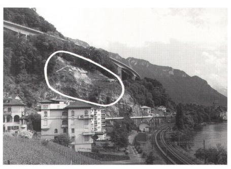
Abb. 1: Die Idylle trügt: Kurz vor Pfingsten hat sich hier in Montreux/Veytaux beim Château de Chillon am Genfer See ein ca. 100 Kubikmeter grosser Teil des Hanges über dem Felsen gelöst. Das weisse Oval zeigt das mit dem Leica System APSWin überwachte Gebiet. Rechts im Hintergrund über dem Wasserschloss von Chillon erkennt man die Dents-du-Midi (3257 mü.M.), wichtige Zeugen der Vermessungsgeschichte.
