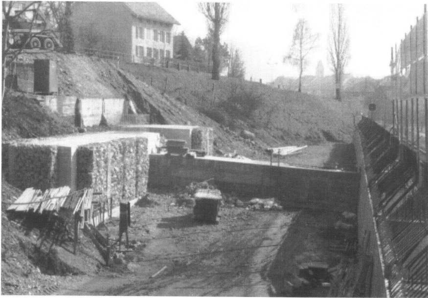
Abb. 2: Fertig erstellter T-Stollen vor der Überdeckung. Man beachte die Drahtschotterkörbe, welche einen möglichst grossen Bodenkontakt gewähren.
