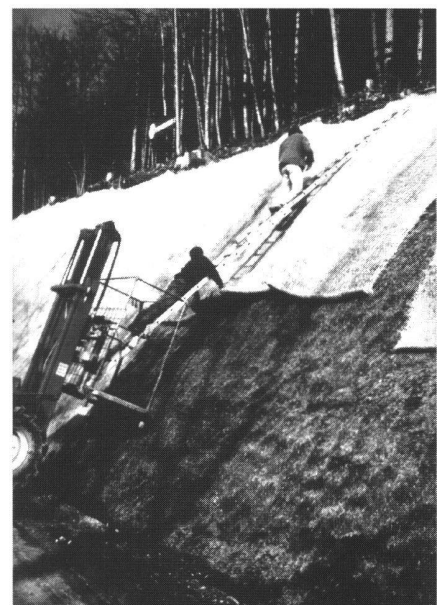
Fig 4: Couverture des semences avec des rouleaux de paille.
