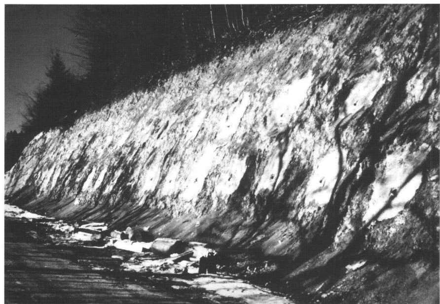
Fig 1: Stabilisation du talus par clouage de plots de gunite.
