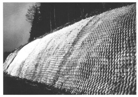
Fig 2: Pose du géotextile alvéolaire.
