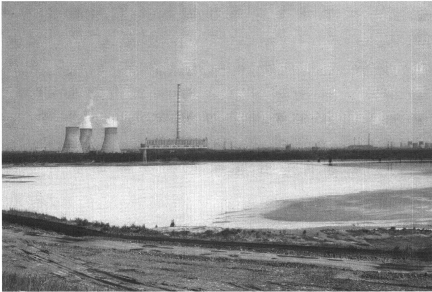
Abb. 3: Bildmitte: Kohlekraftwerk Jaworzno III mit 300 Meter hohem Schornstein. Vordergrund: Absetzbecken für Elektrofilterasche. Hintergrund rechts: Silhouette des Kohlekraftwerkes Jaworzno II.
