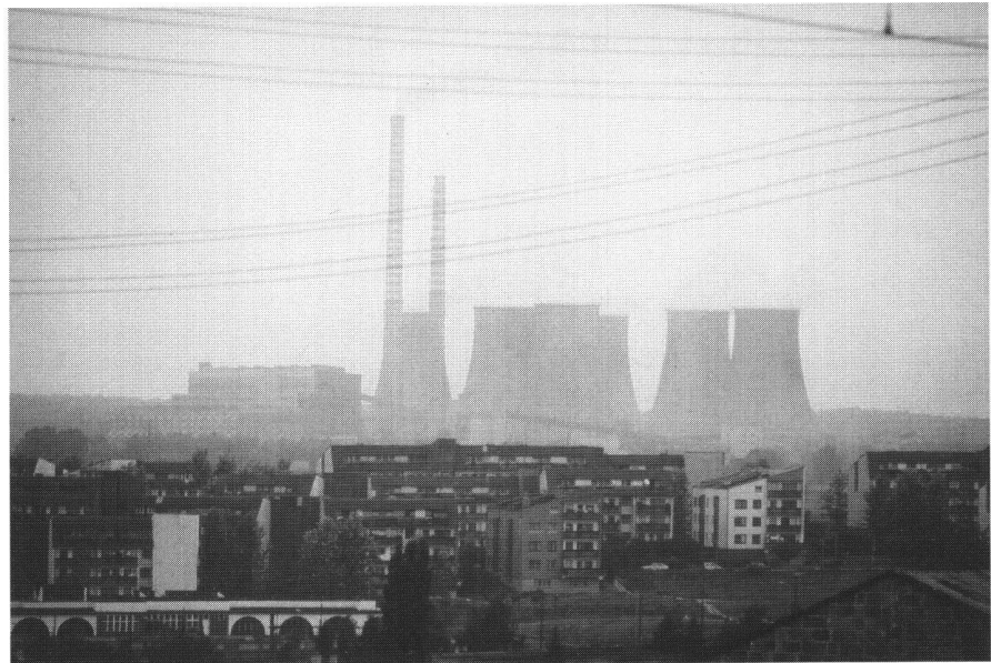
Abb. 1: Kohlekraftwerk Będzin. Fig. 1: Centrale thermique à charbon de Będzin. Rys. 1: Elektrownia w Będzinie.
